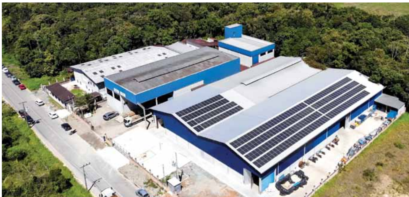
Imagem aérea da fábrica, em Araquari, Santa Catarina
