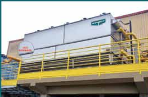
Condensador Evaporativo 100% em aço inoxidável ou aço galvanizado - Opcionais: pintura especial para ambientes agressivos, motores AC e EC, entre outros.
